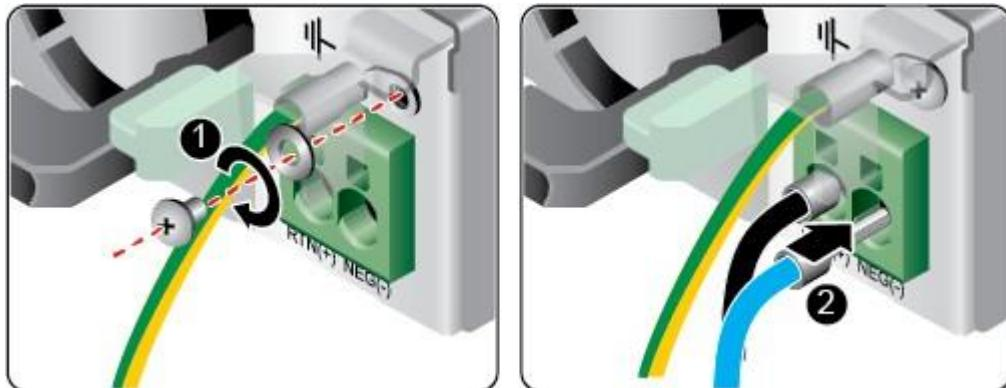
**步骤4** 将电源模块线缆的另一端插入机柜的直流插线排。
